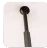
Estructura de sostre reforçada en forma de "+"
