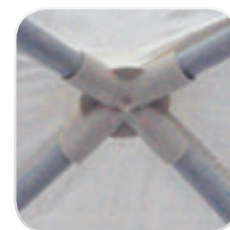
Articulació de les barres metàl·liques al sostre
